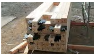
1.接合金物を取り付けられた柱
