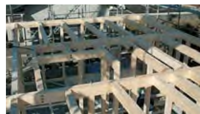
4.組み上がった1階と2階の床梁
