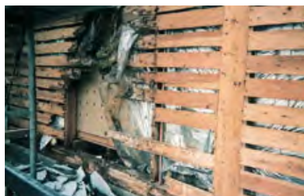
通気層を設けず、壁体内結露などにより下地が腐ってしまった住宅の例
