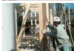
●現場加工が少なく施工精度が極めて高い
