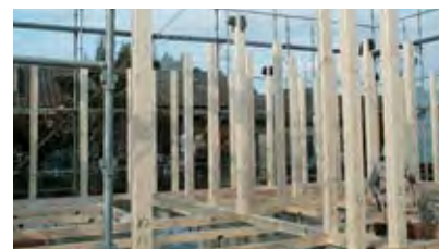
2.組み上がった柱
